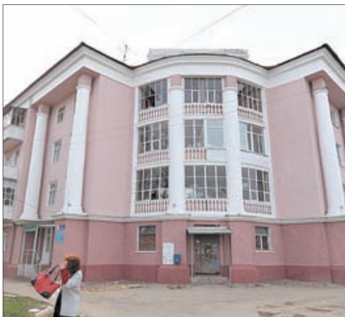
Ул. М.Горького, 2-Энгельса, 52. «По просьбе ТСК меняли ввод в дом, поэтому немного задержались с пуском отопления, к вечеру дадим тепло», — сообщил инженер ПТО ООО «ТермоТехника» Алексей Шимов. Он сам обсчитывал смету: дом планировали полностью заштукатурить. Когда смета проходила экспертизу, то там решили, что нет смысла тратить деньги на внутренний фасад, мол, давайте сделаем только лицевые части. Балконы отремонтировали. Один из слесарей рассказывает, что монтировали канализацию, попросили жителей временно не пользоваться унитазом, но «только стали трубу срезать, а на нас фекалии начали выплывать».
