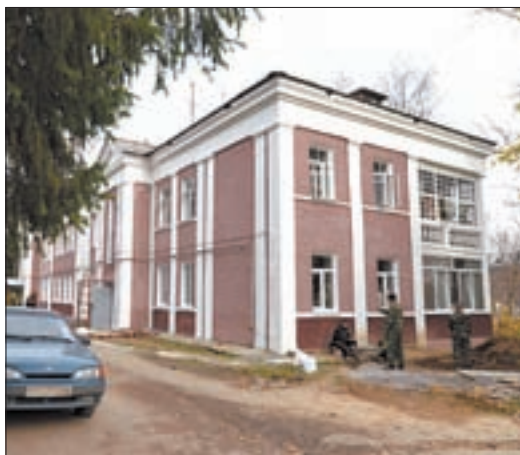
Ул. М.Горького, 4. Отопление есть, заканчивается монтаж водопровода и канализации.
