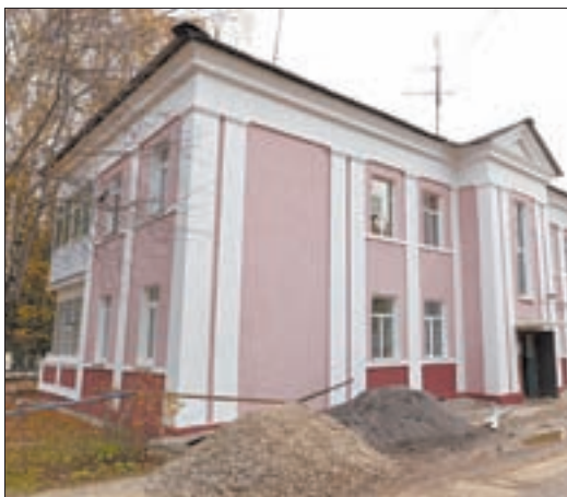
Ул. М.Горького, 6 Отопление запущено, скоро приступят к монтажу водопровода и канализации.
