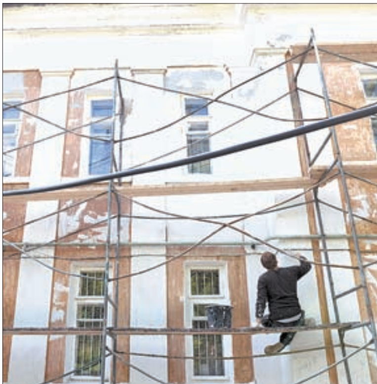
К.Либкнехта, 82. Фасадные работы, а еще ремонт подъездов.
