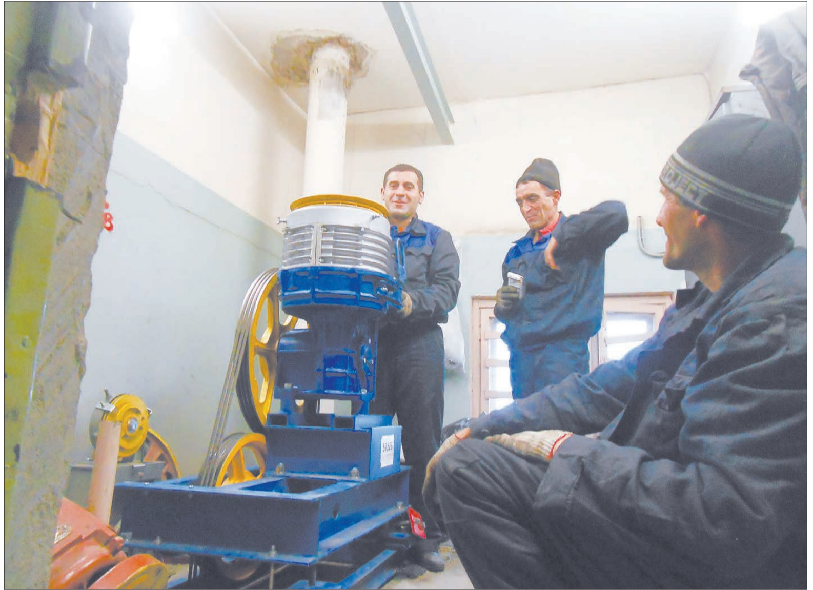
Рабочие подрядной организации монтируют подъемный механизм лифта в одной из многоэтажек Берёзовского. Фото Ольги Желтоног
