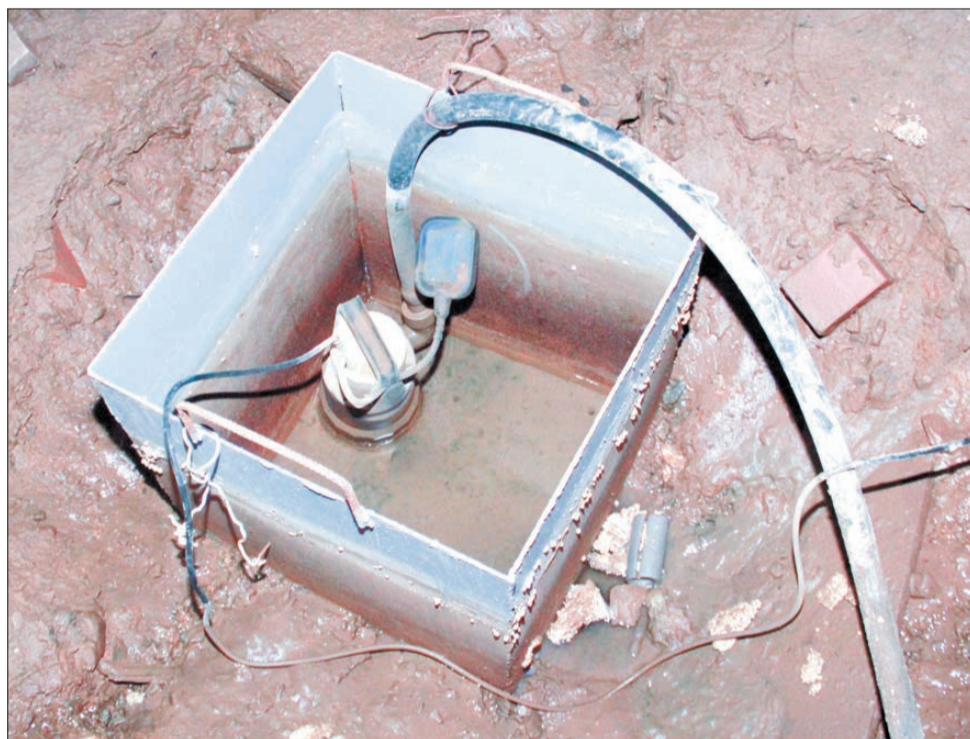
Бьющая из-под земли вода в подвале дома № 6 по ул. Виктора Чечвия. Для откачки воды установлен насос с поплавковой системой включения. Вода прибывает – насос начинает работать, за потребляемую электроэнергию платят жители. Фото Павла Шабельникова
