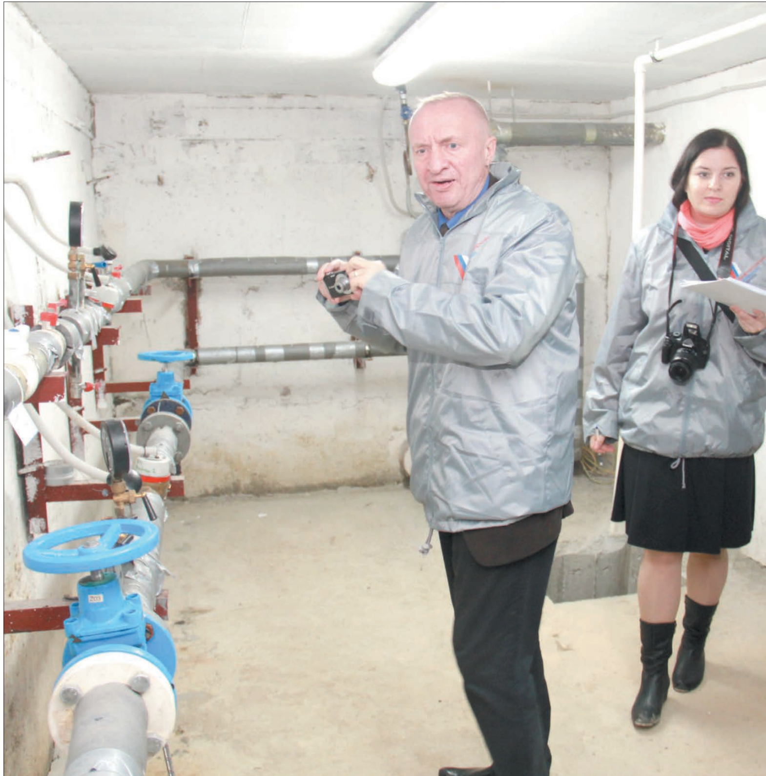
Представители ОНФ Василий Андриянов и Елена Ивашевская осматривают узел ввода горячего водоснабжения и теплоснабжения дома № 2 по ул. Виктора Чечвия. Фото Павла Шабельникова
