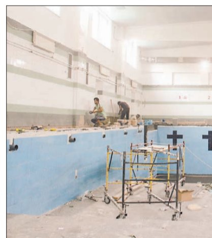
Для чаши бассейна была закуплена плитка двух цветов. Ее рабочие выложили на специально подготовленную многослойную основу, исключающую впитывание воды
