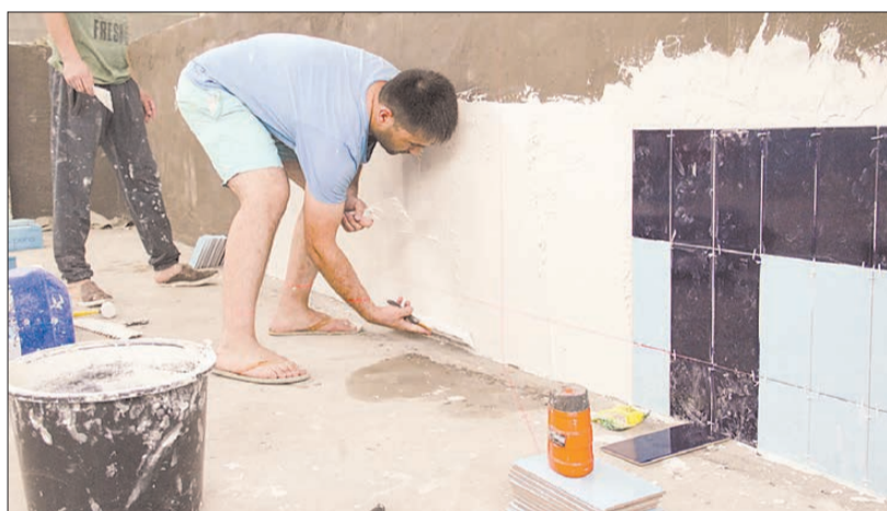
Для чаши бассейна была закуплена плитка двух цветов. Ее рабочие выложили на специально подготовленную многослойную основу, исключающую впитывание воды
