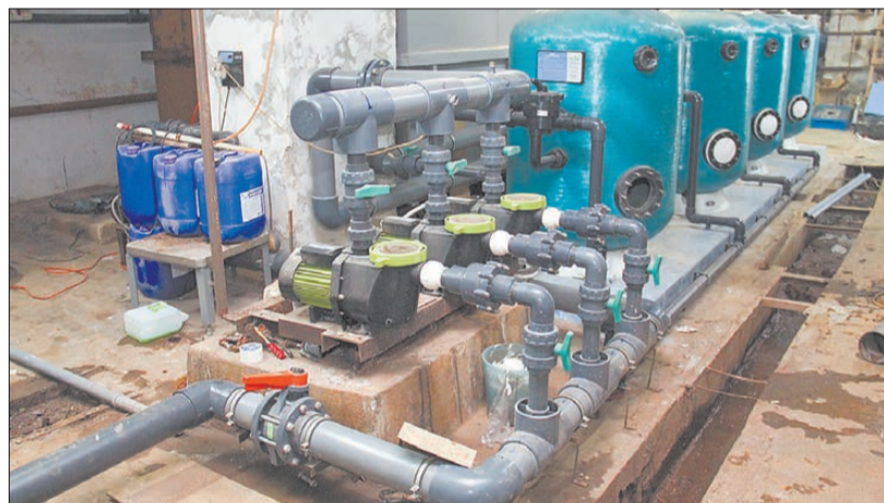
Одним из важных преимуществ новой системы очистки бассейна стала замена металлических частей пластиковыми, что исключает окисление хлорированной воды. Еще одно новшество – автоматизация всего процесса. Фото Павла Шабельникова
