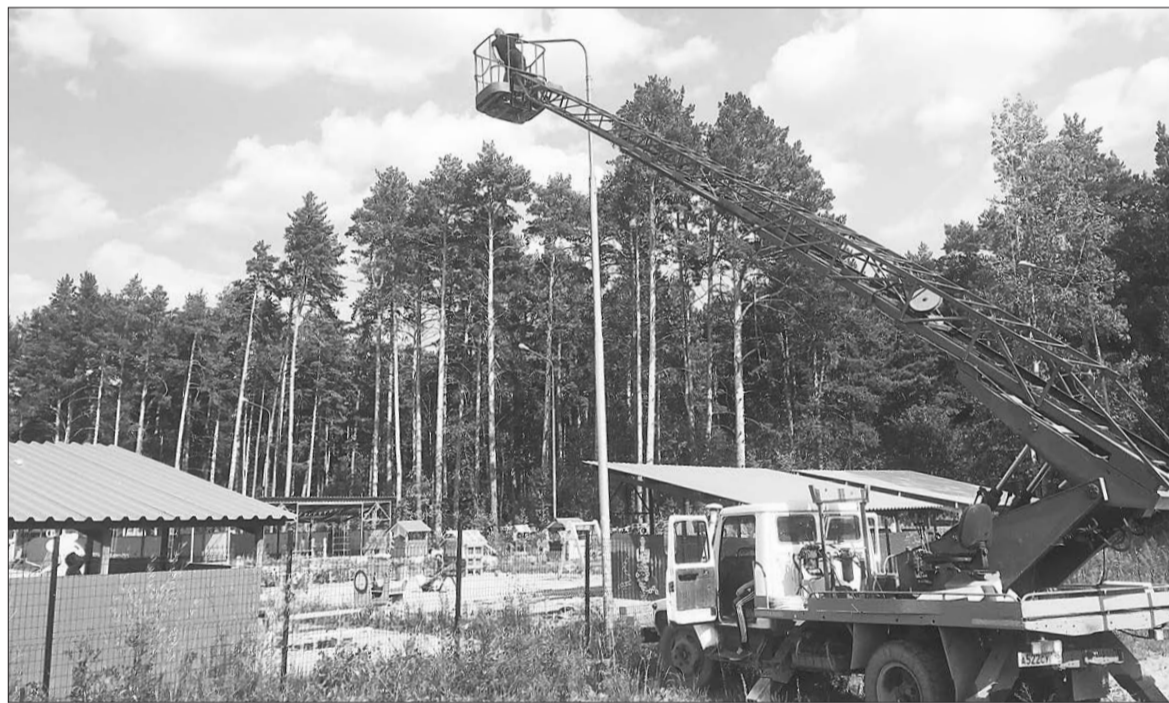
Светильники на территории детсада № 7 отремонтировали 22 августа. Фото Сергея Чепикова
