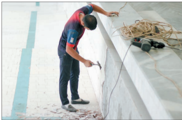
Бригаде рабочих из восьми человек понадобится всего три дня для того, чтобы демонтировать плитку в чаше бассейна. Фото Валентины Завойской
