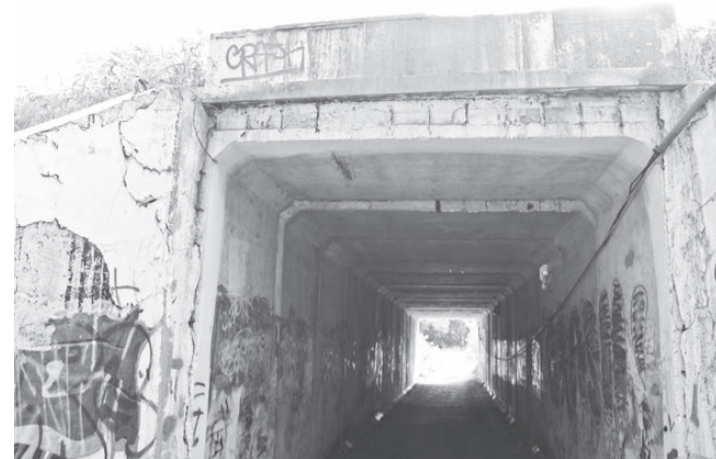
Подземный пешеходный переход соединяет поселок БЗСК и Новоберёзовский микрорайон. Фото Павла Шабельникова
