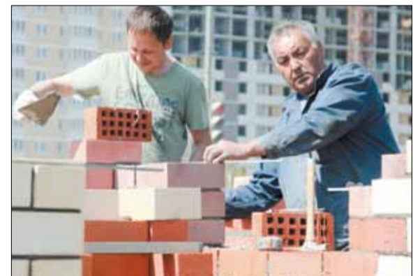
17 мая — стены возводят камешники компании «Термотехника», кирпич предоставил магазин «Строительный двор»
