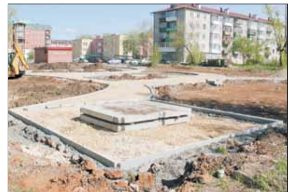
13 мая — Фундаментом дома стали две плиты, скрепленные стальным уголком
