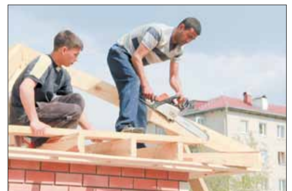
23 мая — Рабочие предприятия «Элита» собирают из досок каркас крыши
