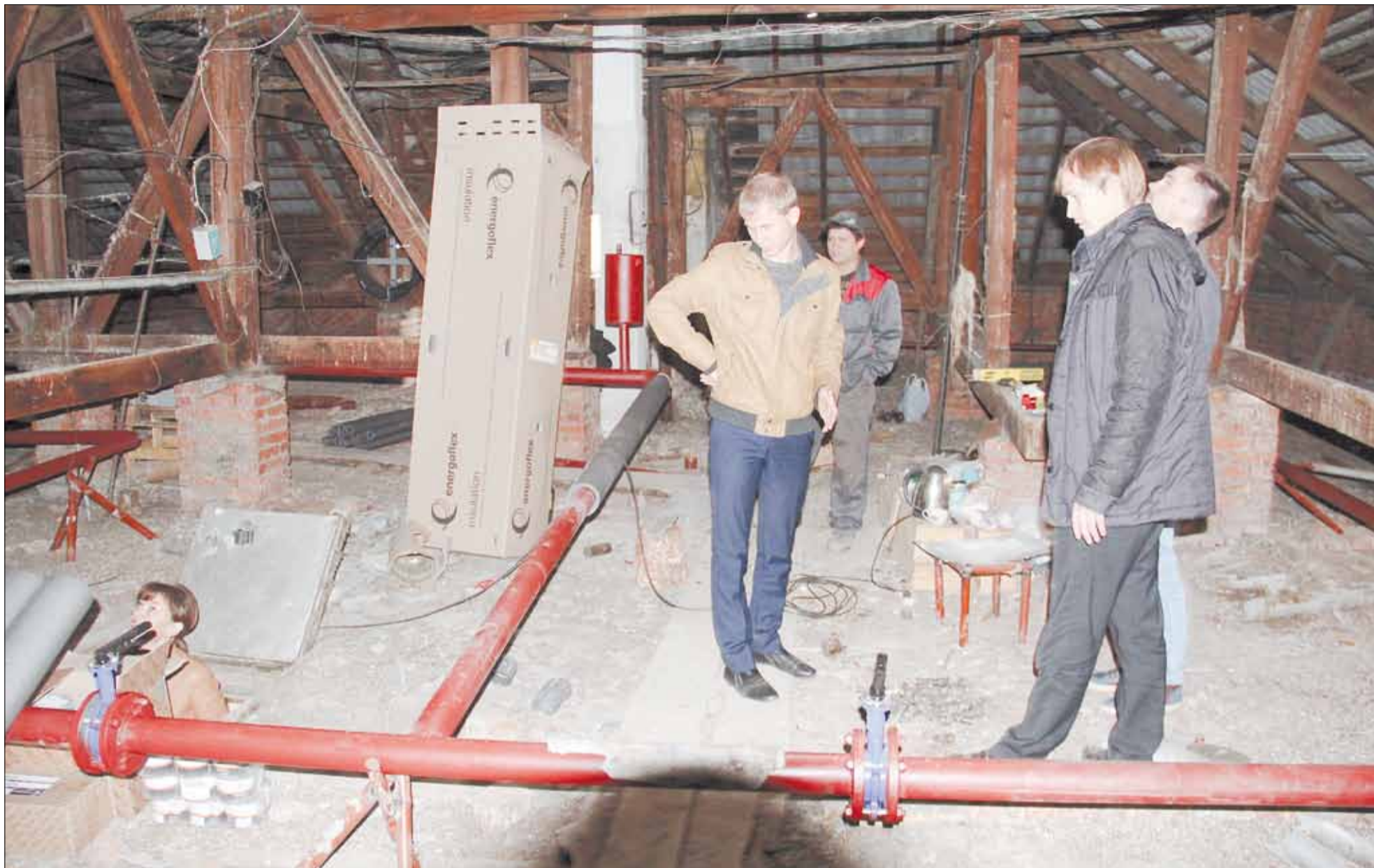
На чердаке дома № 6 по ул. Строителей подрядчик уже смонтировал стальные трубы системы отопления. Ход работ осматривает заместитель главы города Антон Еловиков (в центре). Фото Павла Шабельникова
