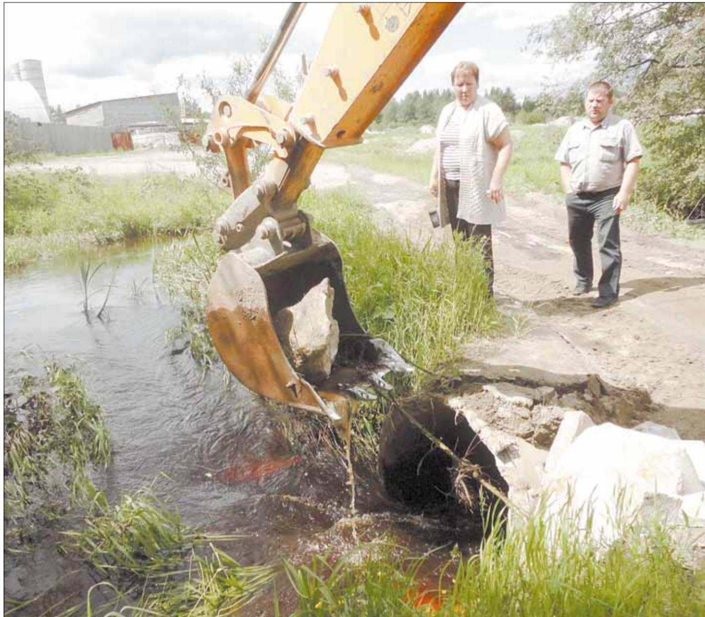
**Камень, мешавший проходу воды в одной из труб грунтового переезда, по просьбе главы поселка Галины Упоровой был убран с помощью прибывшего для починки моста экскаватора.** Фото Олега Манварова
