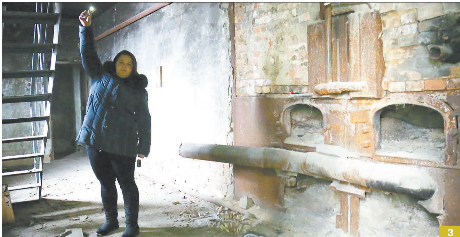
Депутат Елена Бруснянина осматривает технические помещения в ключевской бане – возле заброшенных печей. Тут сейчас пыльно, много сажи. В случае реконструкции здания будет где разместить зрительный зал примерно на 60 мест, танцевальный класс, помещения для детских кружков и секций. Фото Павла Шабельникова
