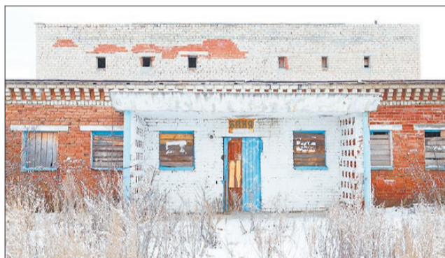
Двухэтажное здание бытового назначения находится в хорошем состоянии и на вид пригодно для реконструкции. Фото Павла Шабельникова
