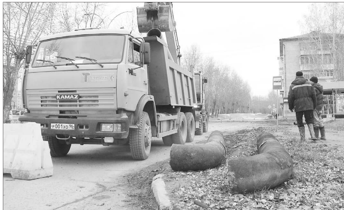
После замены аварийного участка теплотрассы рабочие подрядной компании погрузили куски старых проржавевших труб в самосвал. После этого уложили щебёночную подушку на месте раскопок. Фото Олега Манварова. Нижнее фото: новый асфальт появился на разрытом участке 21 октября, на четвёртый день после начала ремонта. Фото Павла Шабельникова
