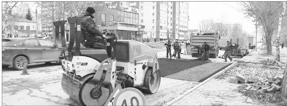
После замены аварийного участка теплотрассы рабочие подрядной компании погрузили куски старых проржавевших труб в самосвал. После этого уложили щебёночную подушку на месте раскопок. Фото Олега Манварова. Нижнее фото: новый асфальт появился на разрытом участке 21 октября, на четвёртый день после начала ремонта. Фото Павла Шабельникова
