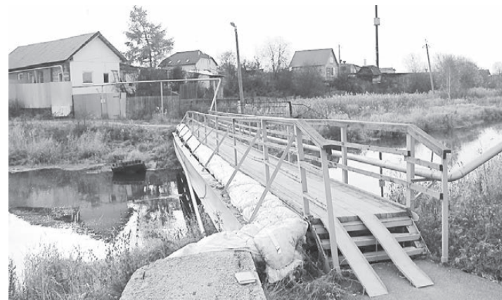
Пандус для колясок, надежные деревянные перила, укрепленные металлическим каркасом, асфальтированная дорожка от моста и до храма и уличные светильники по всему участку — результатом коллективной работы остались довольны и сами депутаты, и, главное, местные жители. Фото пресс-службы Думы Берёзовского
