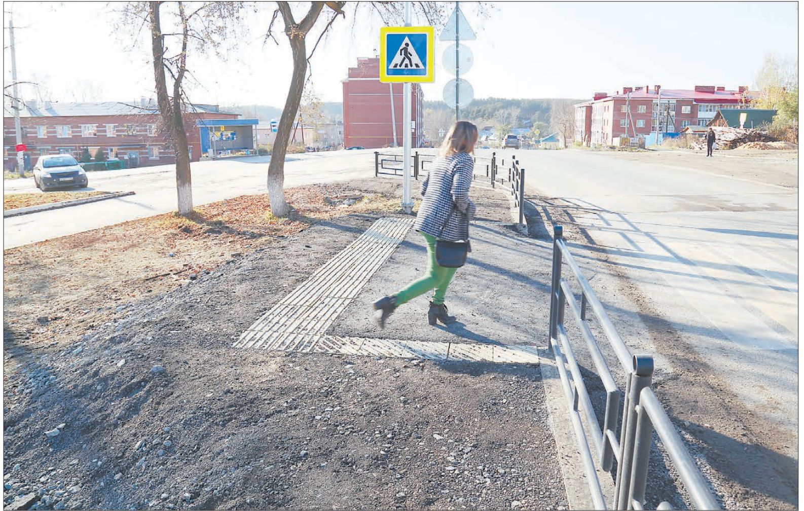
Со стороны крутого обрыва пешеходный переход на ул. Новой в Шиловском микрорайоне строители снабдили лишь тактильными плитками, которые лежат в асфальтовой срезке. По нормам в этом случае полагается ставить перильное ограждение
