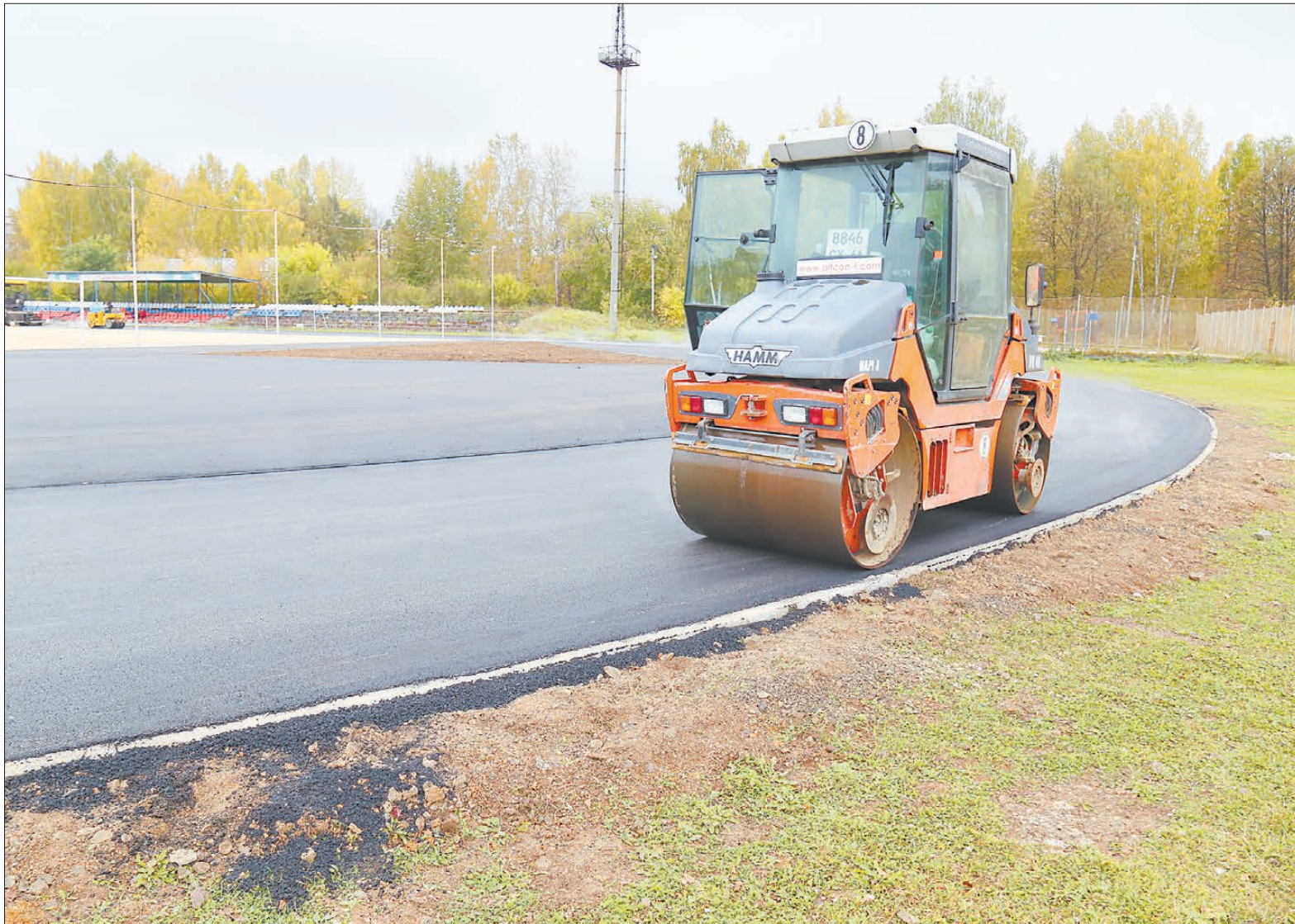
Подрядчик выполнил обязательства — отсыпка, трамбовка поля и асфальтирование беговых дорожек на «Горняке» завершены. Специальное покрытие на них будет укладываться весной. Фото Павла Шабельникова
