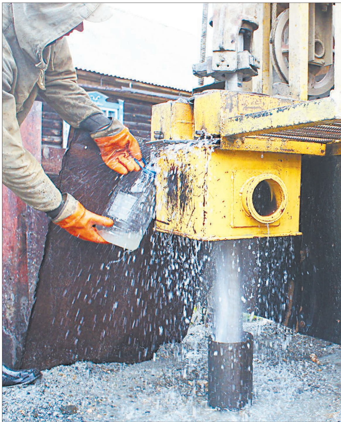
Бурение скважины под воду. Фото из архива Андрея Баздырева
