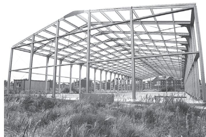
Металлокаркас будущего спорткомплекса, его общая площадь составит около 1500 квадратных метров
