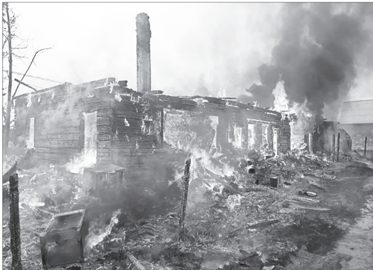
Почти шесть часов огнеборцы тушили деревянный дом в посёлке Ключевске. Пролитка и разбор сгоревших конструкций завершились около полуночи. Фото предоставлено Госпожнадзором
