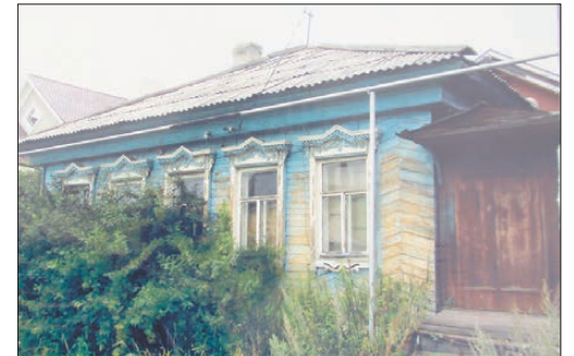
Здание фельдшерско-акушерского пункта ушло в историю. Сейчас оно снесено, а на этом месте построен новый дом. Фото Галины Маховой
