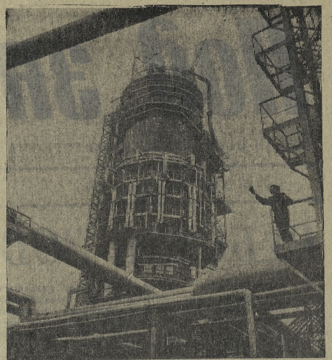
Кременчугский нефтеперерабатывающий завод вырос на Украине за годы минувшей пятилетки. Переработка нефти, которая добывается в восточной части Украинской ССР, ведется здесь тремя наиболее прогрессивными способами: ректификацией, т. е. разделением нефти на фракции, деструкцией углеводородов с помощью установок, носящей название каталитического риформинга, и каталитическим крекингом.
