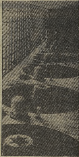
ОАР. Завершены основные работы по строительству Асуанского гидроэнергетического комплекса. С пуском последнего агрегата досрочно достигнута проектная мощность станции — 210000 киловатт. Огромный поток электроэнергии устремился в страну, открывая большие перспективы перед ее промышленностью и сельским хозяйством.
