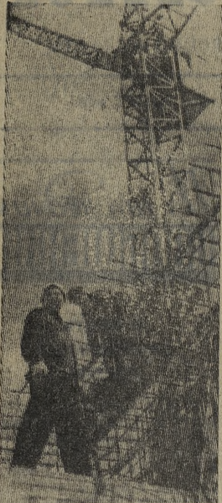
КИРГИЗСКАЯ ССР. Строители Ат-Башинской ГЭС на реке Нарын прилагают все силы к тому, чтобы в нынешнем году станция дала ток жителям высокогорного Тянь-Шаня. На снимке: установка арматурного каркаса здания ГЭС. На переднем плане — лучший электросварщик Анатолий Лугинин. Фото Н. ЖИГАНОВА.
