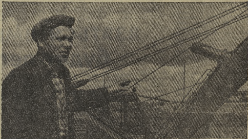
Сабит Закиров уже шесть лет работает машинистом экскаватора в Уралспецстрое. Он — отличный механик. Сейчас Сабит трудится на строительстве цеха «В-1» на Новотрубном заводе и нормы выполняет на 150 процентов.
