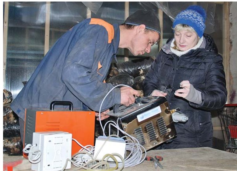
Монтаж нового оборудования для вентиляции
