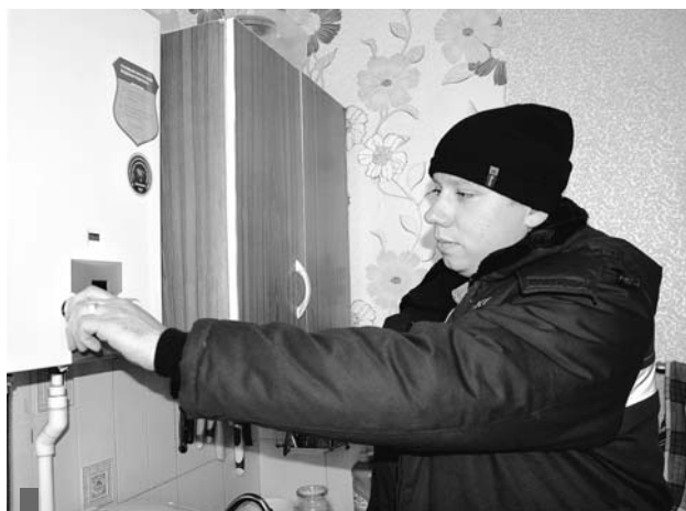
Проверка срабатывания датчика тяги в газовой колонке
