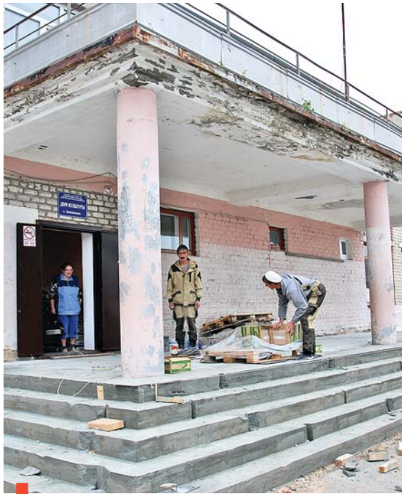
Работы по реконструкции крыльца
