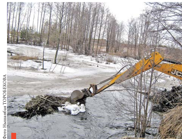
Завершается разбор бобровой плотины
