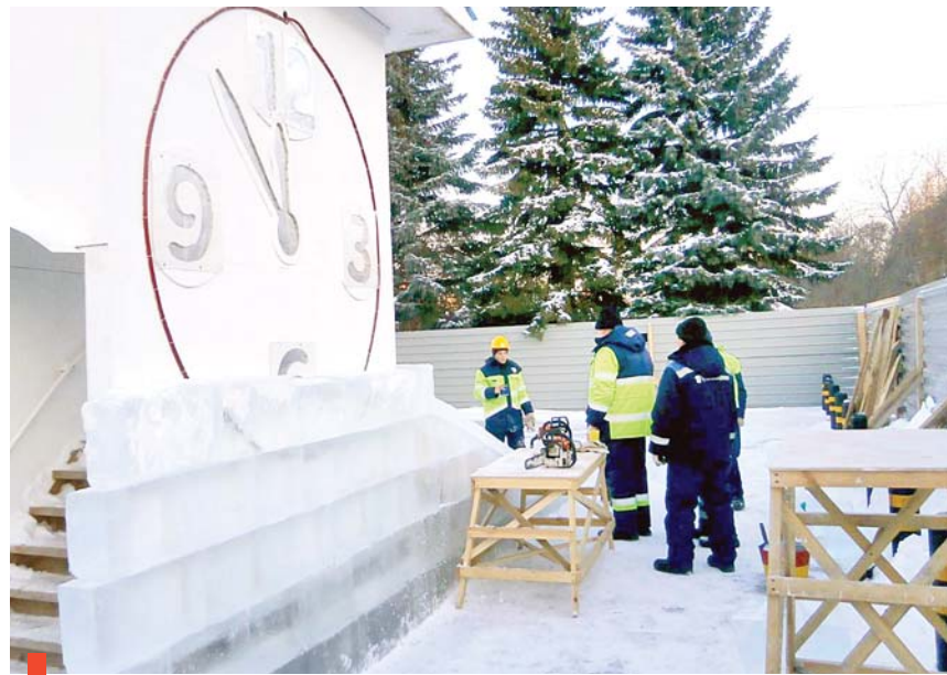
Монтаж горки с двойным скатом ведет бригада ОАО «Сухоложскцемент»
