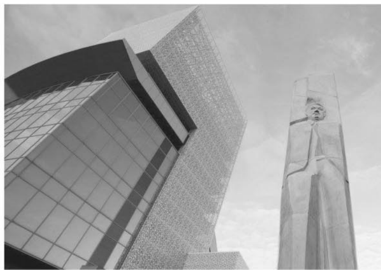
Работы по созданию центра велись с 2011 года. Сейчас это пятиэтажное здание многофункциональной направленности.
