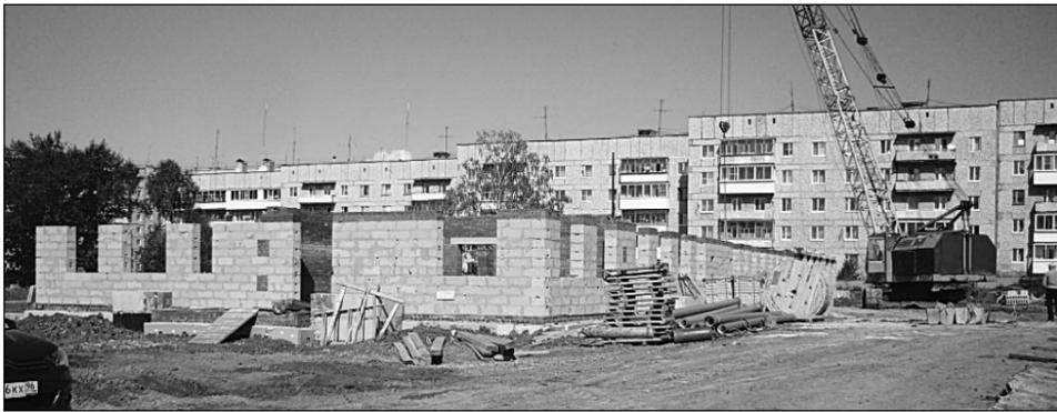
**ПРОДОЛЖАЮТСЯ** работы на строительстве детского сада в Кушве. Строители ООО "СтройАтлант" (директор М.Зиганшин) работают в три смены. Они стремятся до конца июля завершить кладку стен первого этажа и приступить к возведению второго. Параллельно идут работы по монтажу инже-
