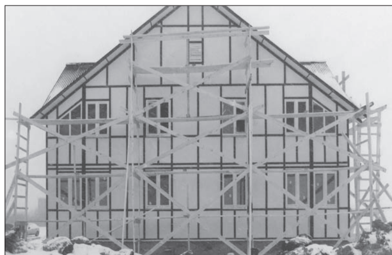
Фасад будущего дома в лесах.
