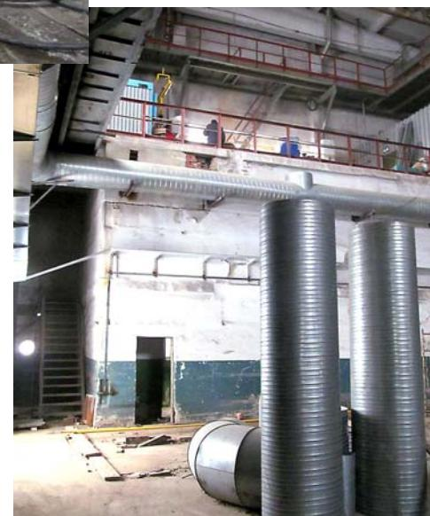
пе ведутся работы по газоснабжению нового участка, монтажу систем отопления, освещения... Смонтированы воздуховоды, возведена наружная эстакада для подведения силового кабеля, «Базис» приступает к работам по строительству встроенных помещений и устройству бетонных полов.
