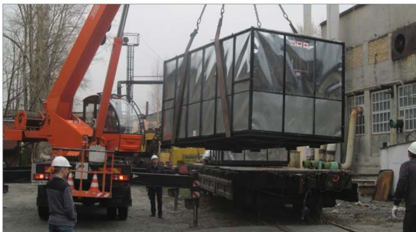
Идёт разгрузка нового оборудования.
