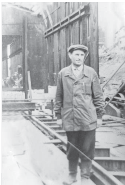
Техник-строитель Михаил Исакович Бей у строящейся туннельной печи.
