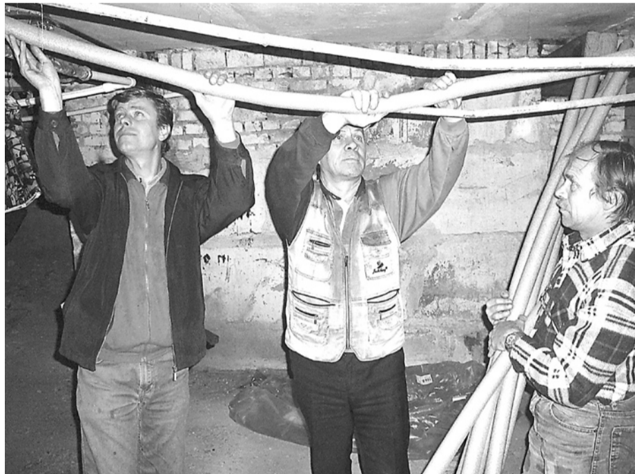
Теплоизоляцию труб центрального отопления в подвале дома N 39 на улице Кунавина производят работники ООО «Жилье» И.В. Сухоруков, В.Д. Гашков и В.П. Петренко.
