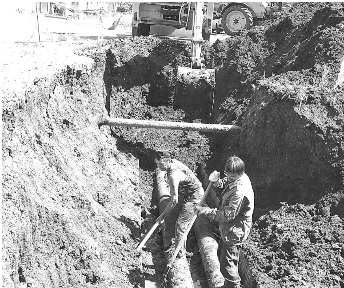
Зачисткой траншеи на улице Гагарина занимаются работники ООО «ТЭЖ» С.Н. Шаповалов и А.С. Санин.
