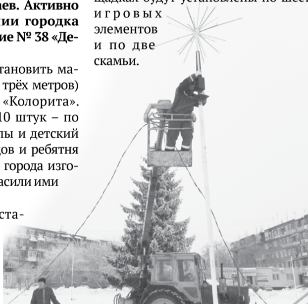
Работники ООО «ПМК-2» устанавливают «фейерверки» возле ёлки.
