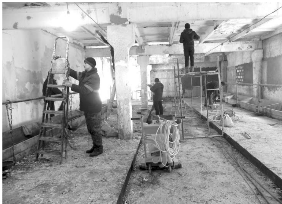
Продолжается работа по реконструкции новых помещений.
