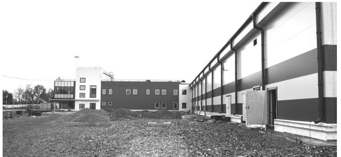
Строительные работы на мясокомбинате подходят к концу.
