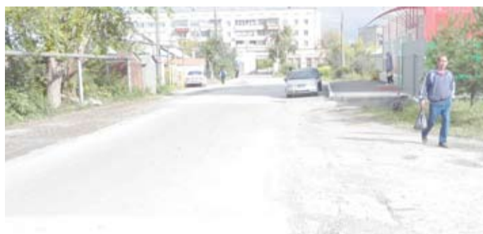
На улице Крылова произведен частичный ремонт асфальтобетонного покрытия.
