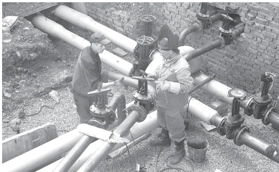
Работники МУП «БТС» Владислав Минигулов и Артем Чугунов завершают капитальный ремонт разводки магистральной отопительной сети у дома №7 на ул. Октябрьской.
