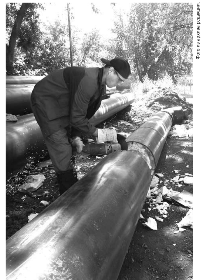
Ремонт тепловой магистрали.
