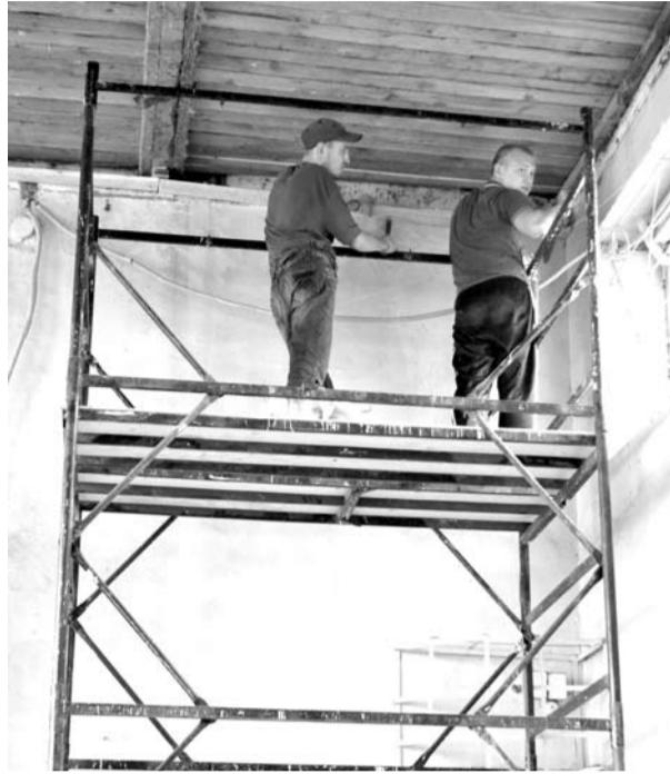
Ремонт спортзала в Тыгишской школе.
