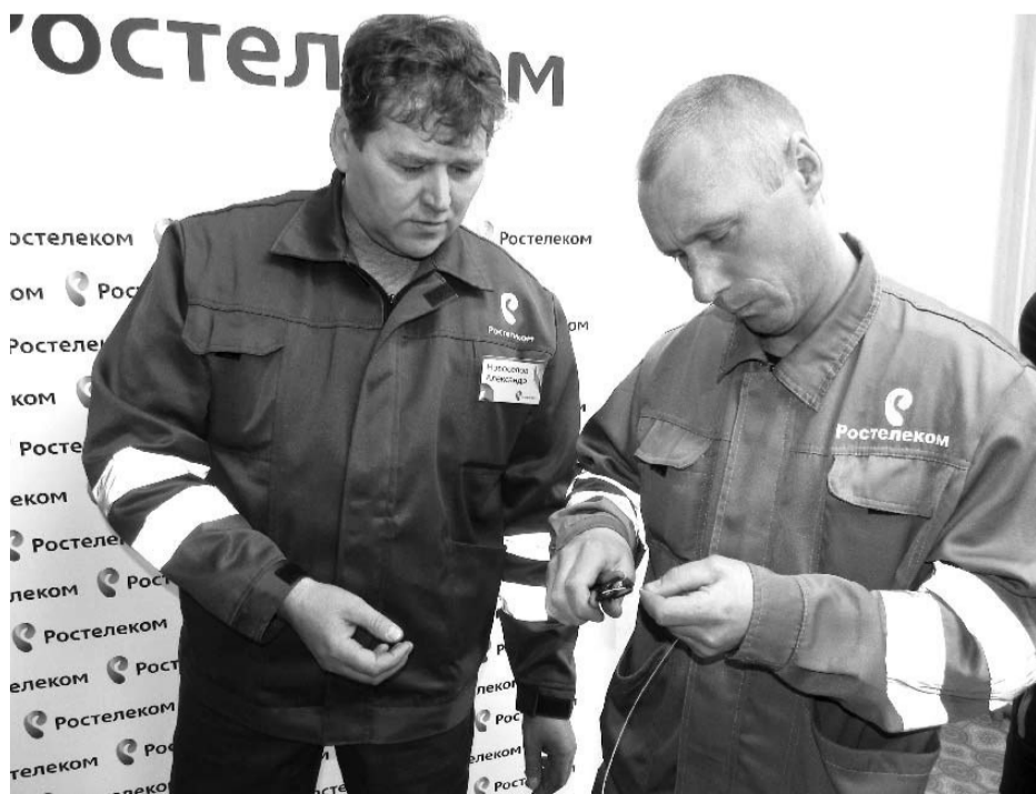
Работники ЛТЦ «Ростелекома» Александр Новосёлов и Александр Ярославцев готовятся подключить к сети 50-й километр оптоволоконного кабеля.
