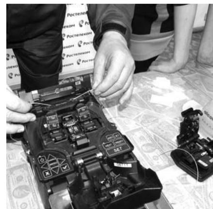
На этом аппарате свариваются оптические волокна кабеля.
