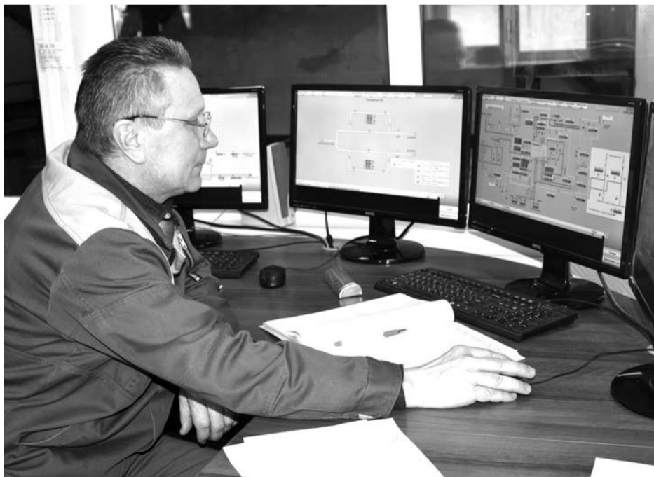
Начальник смены мити-ТЭС ОАО «БГК» Сергей Соколов из операционного зала контролирует производство и электрической, и тепловой энергии.
