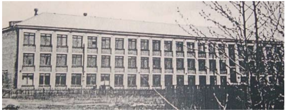
В 1964 г. построено одно из зданий Глуховской средней школы.
