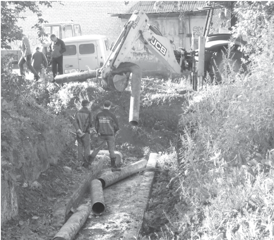
Работники МУП «БТС» ведут демонтаж старых труб на участке у перекрестка улиц Гагарина и Партизанской.
