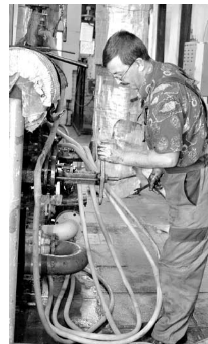
Работы в котельной № 5 подходят к завершению. На снимке: слесарь Алексей Прожерин проводит ревизию арматуры линии подпитки внутренних сетей.
