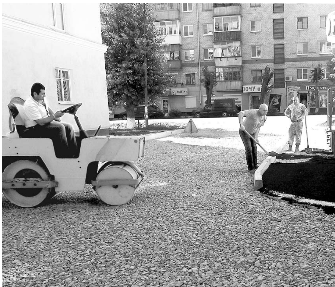
Подрядчиком работ по благоустройству дворовых территорий является ИП Авакян Д.Е. На фото: работники этого предприятия асфальтируют тротуар у дома №22 на ул. Гагарина.
