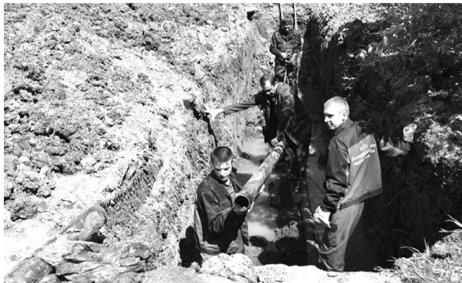
С 17 мая, через два дня после окончания отопительного сезона, начались опрессовочные работы с целью выявления ветхих участков тепловых сетей. На фото: работники МУП «БТС» занимаются заменой труб на одном из выявленных участков – Мира, 2.
