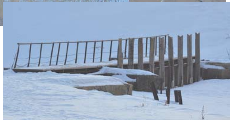
Плотина – сооружение, созданное для защиты от паводков. Пока Глуховская плотина утопает в снегу. Но даже растаявший снег не должен вызвать затопления – наш городской округ считается паводкобезопасным.
