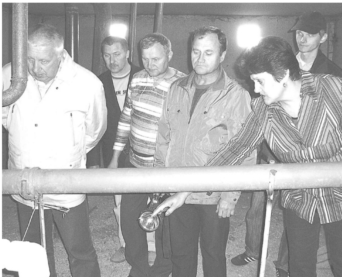
Члены комиссии осматривают состояние теплосети в подвале дома N 20 1 квартала.
