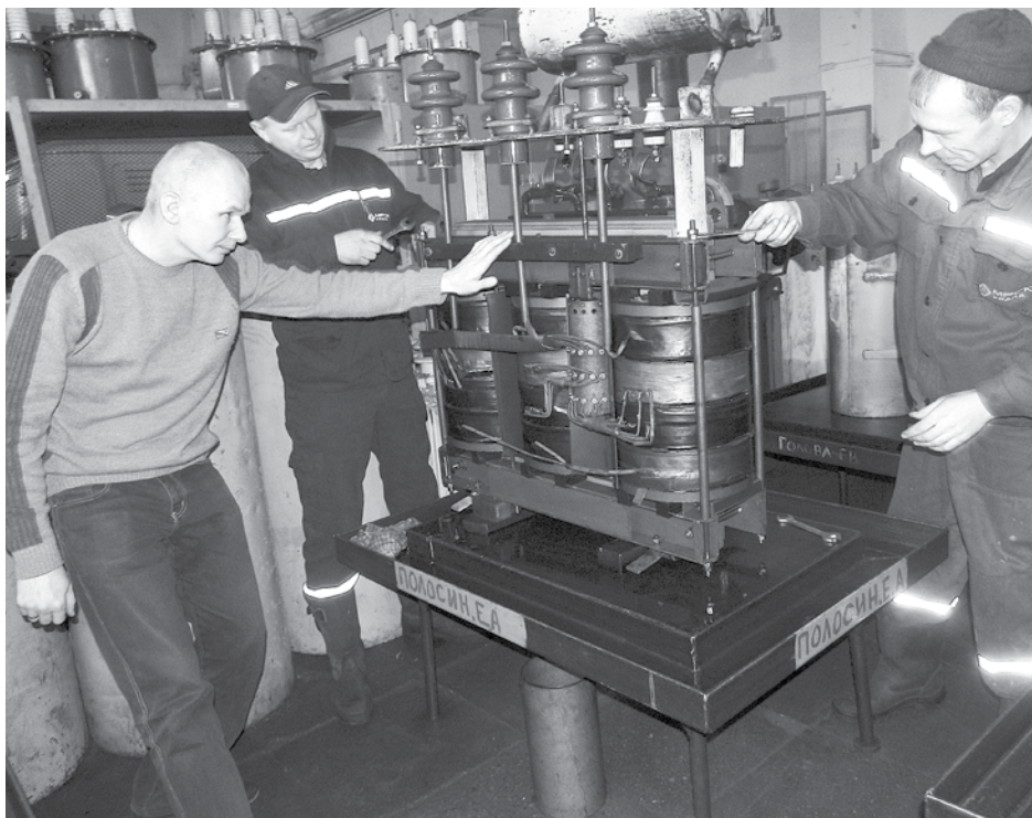
На ремонтной базе ВЭС восстанавливают электрооборудование, вышедшее из строя. Ремонт трансформатора для надежности работы трансформаторного пункта производят три Евгения – Лоскутов (слева), Парохонько и Полосин.
